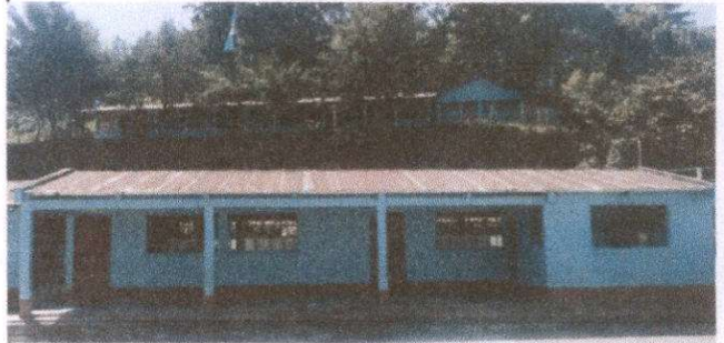
Foto 4: Sustrucción de vidrios
