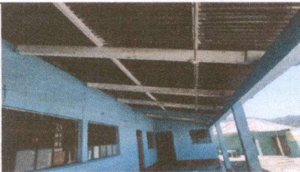
Foto 5: Sustrucción de estructura de soporte
