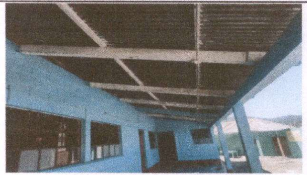
Foto 2: Sustrucción de cubierta
